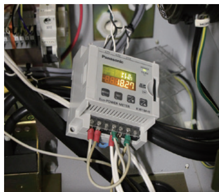
簡易電力センサー（弘前工場 NC旋盤機の測定風景）
